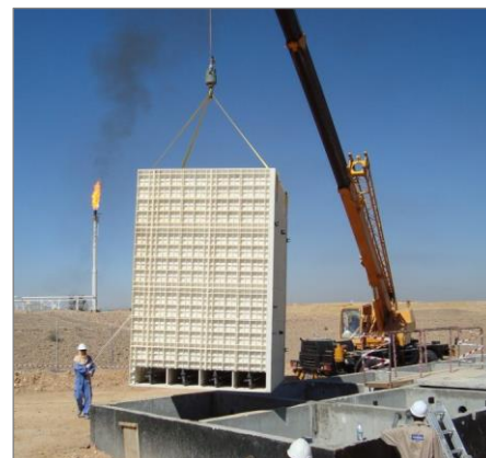
Instalación de Bio-Reactor en Yemen
